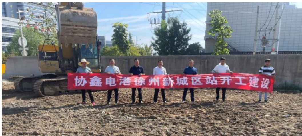
图 47 协鑫集团徐州市新城换电站开工建设
