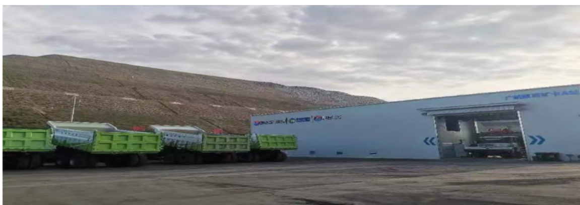
图 39 广纳蒙西矿山换电站实景图
