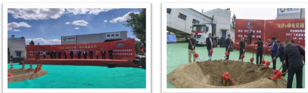
图 43 朔州“光伏+绿色交通”项目现场奠基图
