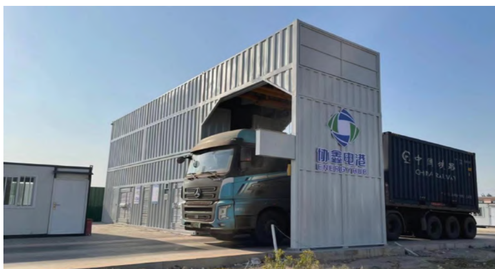
图 37 武安荣兰线A站实景图
