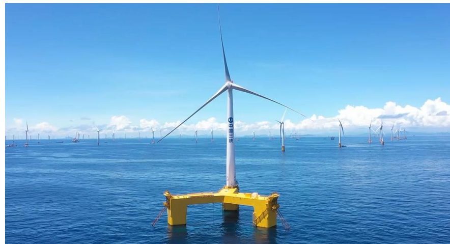
图：三峡引领号漂浮式风电机组
