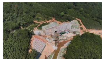
注：图为已开工的浪江抽水蓄能电站
