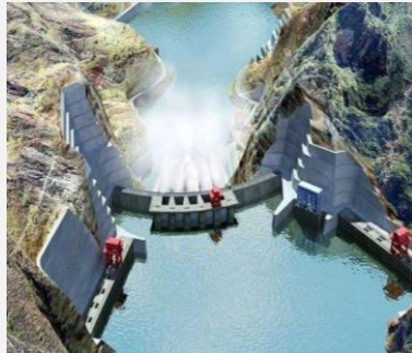
乌东德水电站
