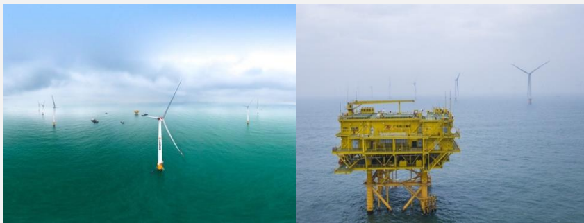
图10 珠海金湾海上风电场项目掠影
