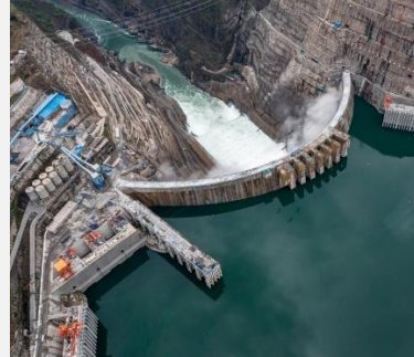
白鹤滩水电站
